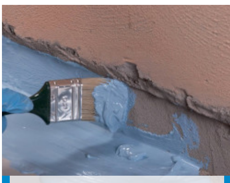
Nakładanie Mapelastic AquaDefense Zero pędzlem na połączenie ściana-podłoga przed nałożeniem Mapeband
