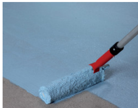
Nakładanie pierwszej warstwy Mapelastic AquaDefense Zero na podłogę
