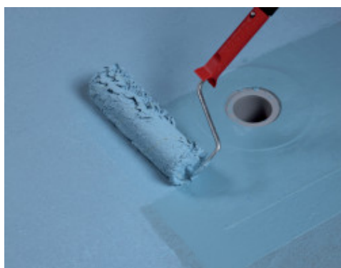
Nakładanie wałkiem drugiej warstwy Mapelastic AquaDefense Zero
