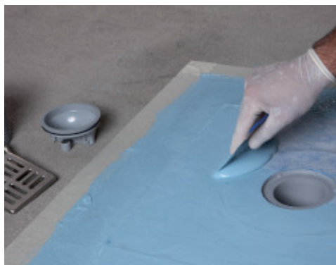
Rozprowadzanie Mapelastic AquaDefense Zero przy uszczelnianiu odpływu Drain Vertical
