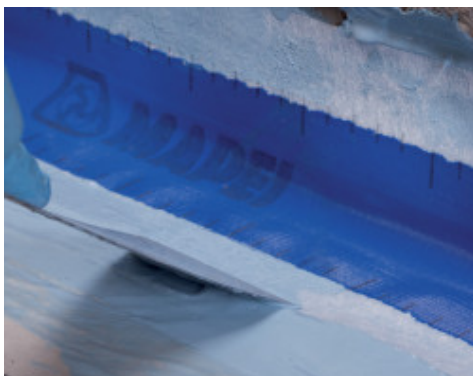
Taśma Mapeband na połączeniu ściana-podłoga przyklejona na Mapelastic AquaDefense Zero
