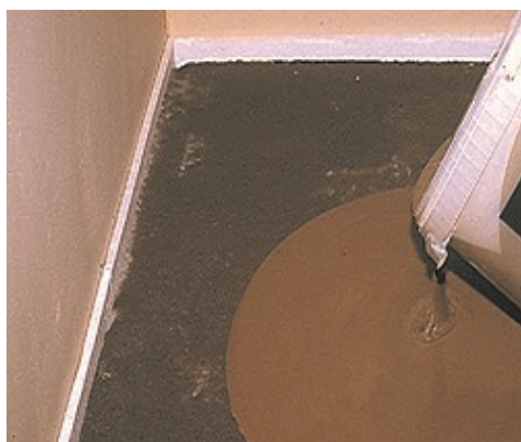
Wylanie masy Novoplan 21 na podłoże
