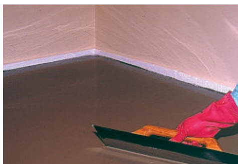
Rozprowadzanie masy Novoplan 21 przy użyciu metalowej szpachli na powierzchni zagruntowanej preparatem gruntującym Primer G Pro
