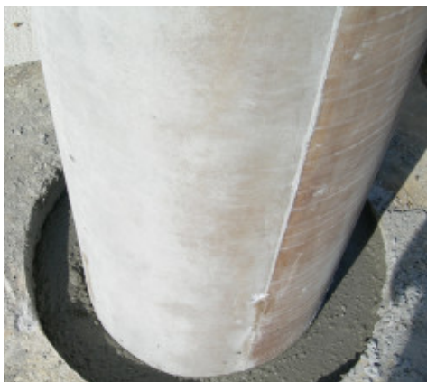
Kotwienie prefabrykowanego filaru
