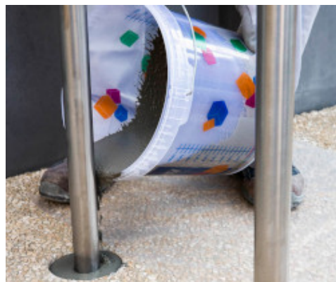
Kotwienie elementów małej architektury miejskiej
