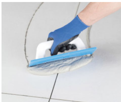
Spoinowanie płytek przy pomocy pacy gumowej
