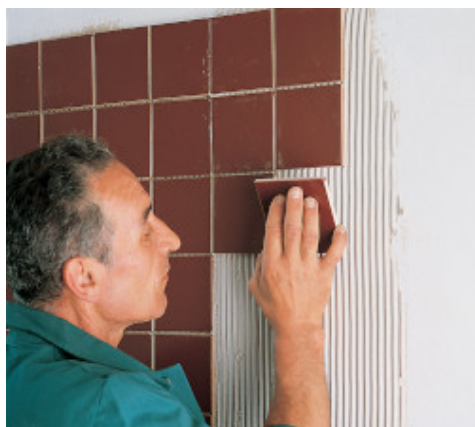
Montaż płytek na ścianie gipsowej
