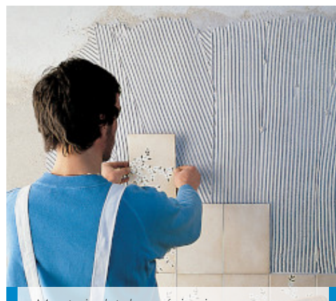
Montaż płytek na ścianie z tradycyjnym tynkiem
