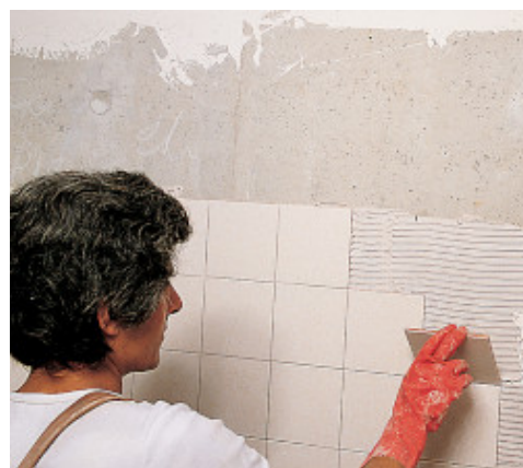
Montaż płytek na ścianie betonowej
