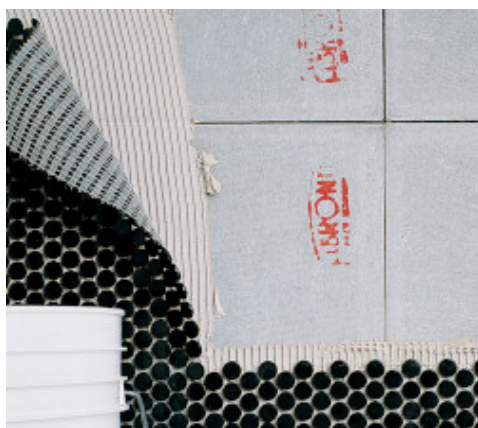
Montaż mozaiki na fibrobetonie
