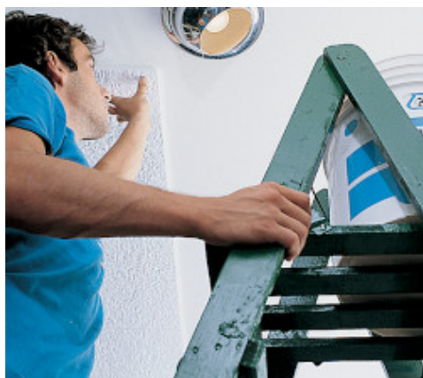
Montaż płyt styropianowych na suficie
