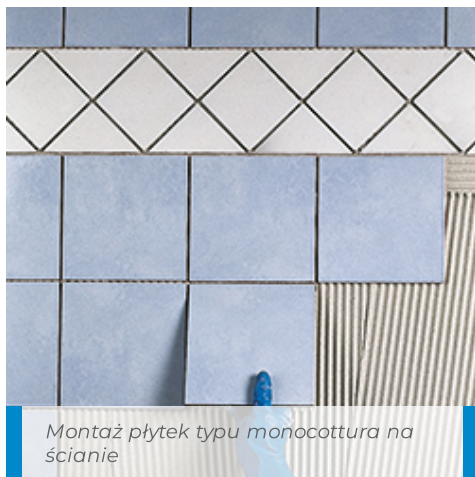
Rozprowadzanie Adesilex P9 Zero w kolorze szarym
