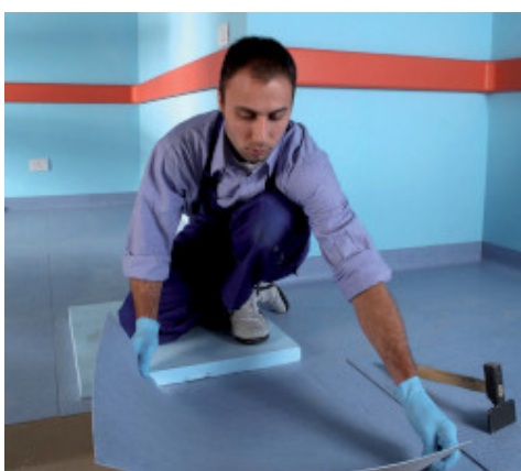
Montaż arkuszy wykładziny winylowej
