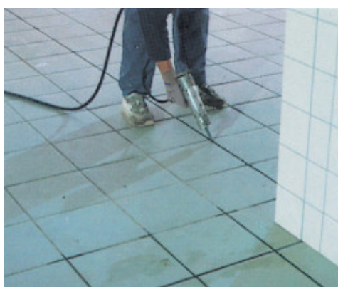
Spoinowanie posadzki za pomocą pistoletu pneumatycznego
