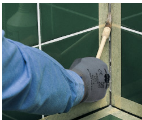
Gruntowanie boków szczeliny przy użyciu Primer FD
