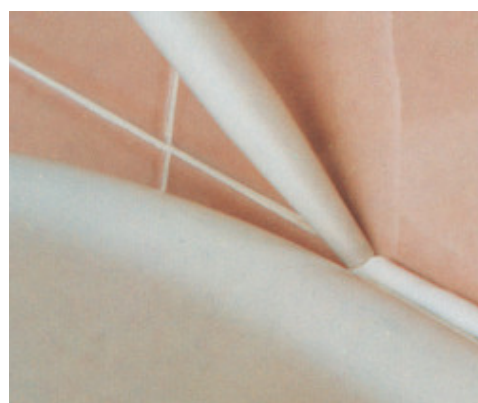
Spoinowanie ceramiki sanitarnej przy użyciu Mapesil AC
