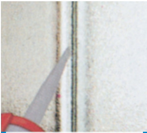
Spoinowanie elementów szklanych
