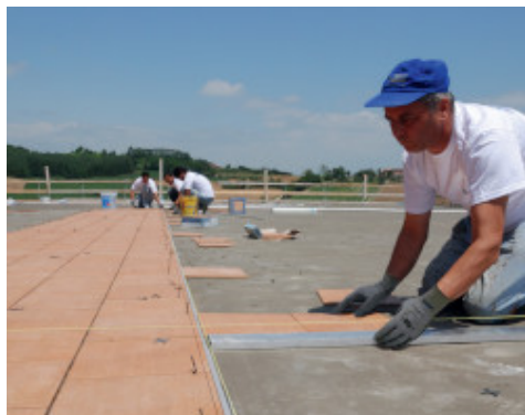
Montaż płytek ceramicznych z zastosowaniem Kerabond TE + Isolastic
