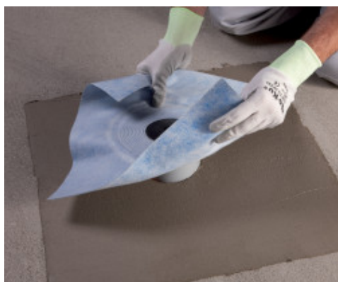
Montaż Drain Vertical na Mapelastic Zero
