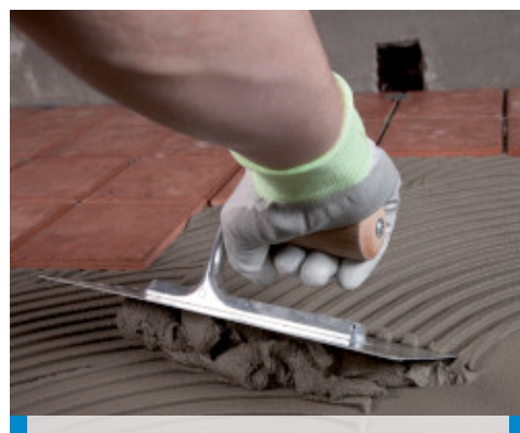
Montaż płytek na zaprawie klejącej Granirapid na wykonanej uprzednio hydroizolacji Mapelastic Zero
