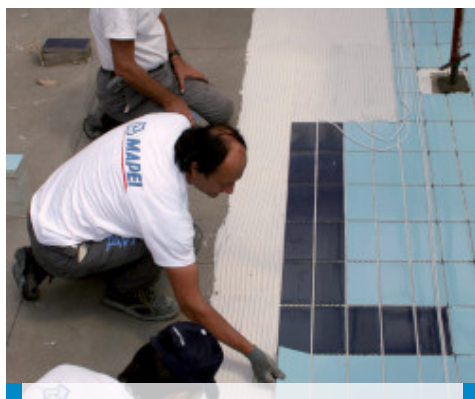
Montaż płytek ceramicznych na warstwie hydroizolacji Mapelastic Zero
