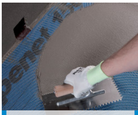
Rozprowadzanie hydroizolacji Mapelastic Zero na siatce Mapenet 150
