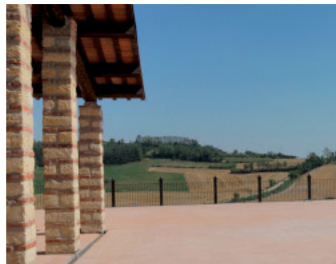
Prywatny taras w Cereseto (Włochy) zabezpieczony hydroizolacją Mapelastic Zero
