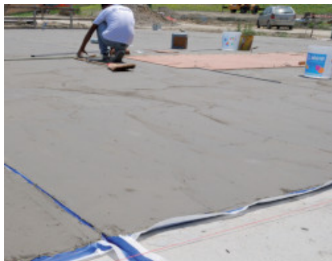
Hydroizolacja powierzchni jastrychów z zastosowaniem Mapelastic Zero i Mapeband
