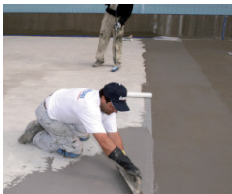
Hydroizolacja basenu z zastosowaniem Mapelastic Zero
