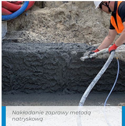
Wyprofilowana powierzchnia zaprawy
