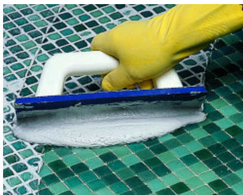
Spoinowanie mozaiki szklanej z użyciem Keracolor FF zmieszanim z Fugolastic
