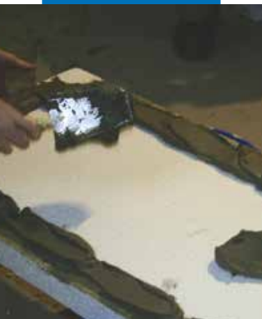
Nakładanie kleju Mapetherm do styropianu na płytę przy pomocy pacy
