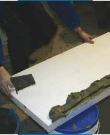
Nakładanie kleju Mapetherm do styropianu na płytę izolacyjną
