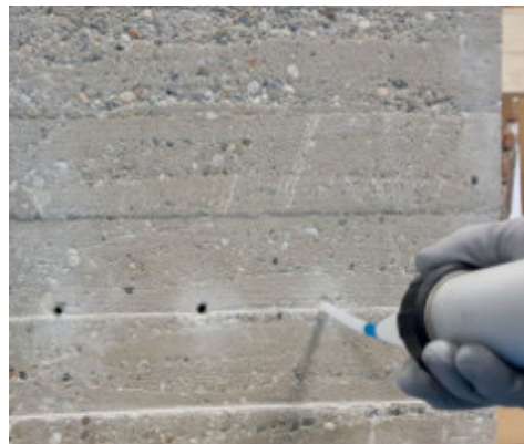
Wykonywanie bariery chemicznej w ścianie betonowej
