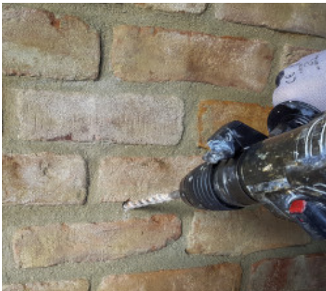
Wiercenie szeregu otworów w murze
