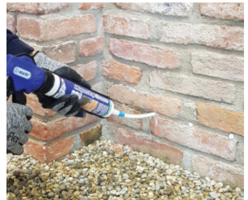
Wycisnąć krem iniekcyjny z kartusza wypełniając wszystkie otwory
