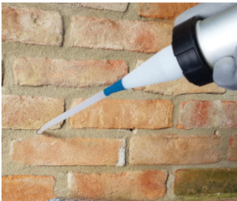
Wtłoczyć krem iniekcyjny przez rurkę wypełniając wszystkie otwory
