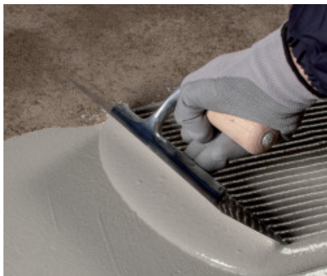
Nakładanie pierwszej warstwy Mapelastik Turbo
