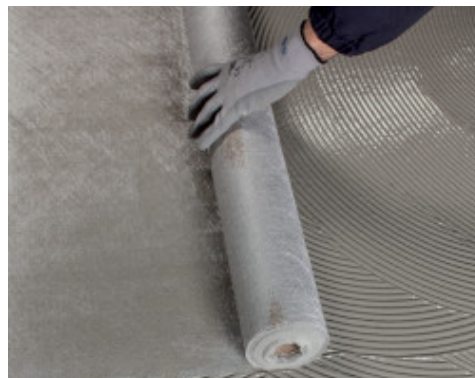
Układanie Mapetex Sel na pierwszej, jeszcze świeżej warstwie Mapelastik Turbo
