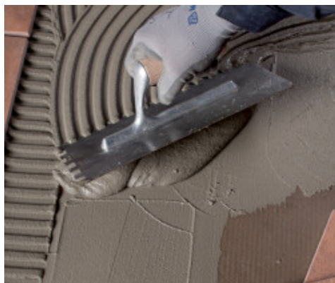
Przyklejanie płytek za pomocą zaprawy klejącej Elastorapid
