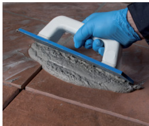
Spoinowanie płytek zaprawą do spoinowania Ultracolor Plus
