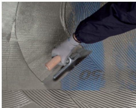
Wtapianie siatki Mapenet 150 w pierwszą, jeszcze świeżą warstwę Mapelastik Turbo
