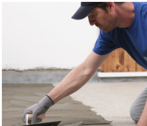
Rozprowadzanie warstwy kleju pacą zębatą nr 5
