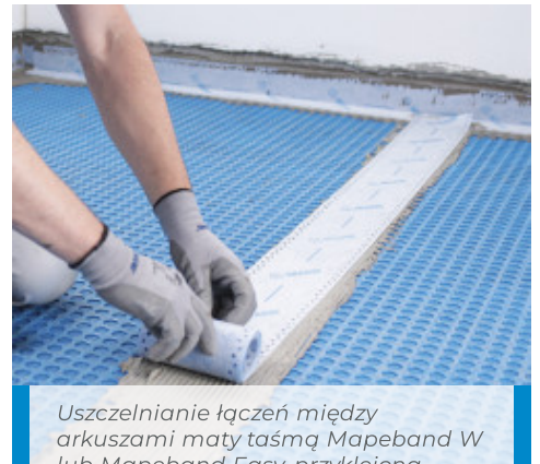
Układanie Mapeguard UM 35
