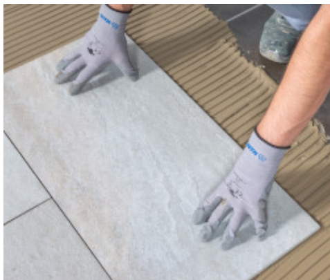
Układanie ceramiki imitującej kamień na istniejącej posadzce
