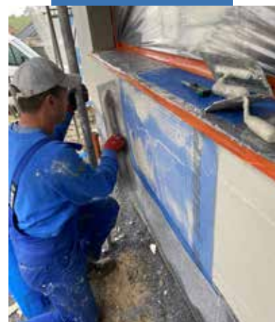
Wtapienie siatki zbrojnej w warstwę zaprawy
