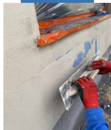
Szpachlowanie siatki zbrojnej
