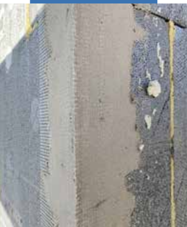
Montaż siatki zbrojnej w narożu budynku
