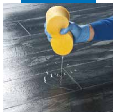
Zwilżanie wodą zaspoinowanej posadzki przed czyszczeniem
