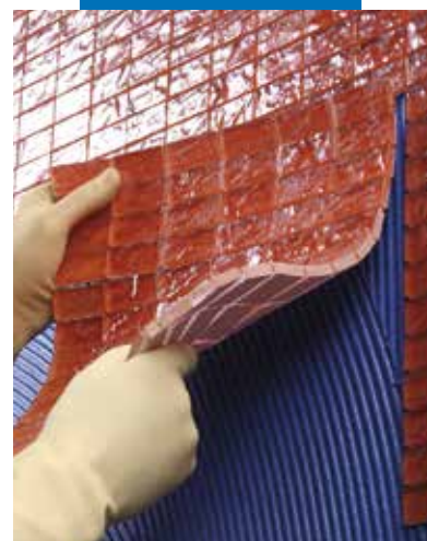
Układanie mozaiki szklanej na ścianie przy użyciu Kerapoxy Design
