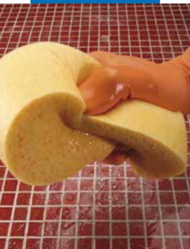
Zwilżanie wodą zaspoinowanej powierzchni przed czyszczeniem
