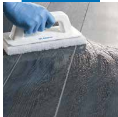
Wstępne czyszczenie powierzchni płytek gąbką Scotch Brite®
