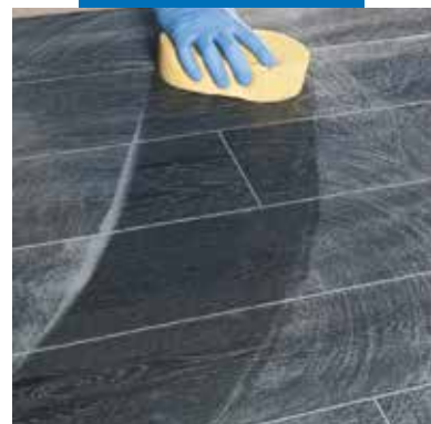
Czyszczenie i profilowanie spoin gąbką celulozową MAPEI
