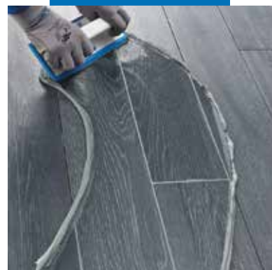
Rozprowadzanie Kerapoxy Design na płytkach drewnopodobnych za pomocą gumowej pacy
