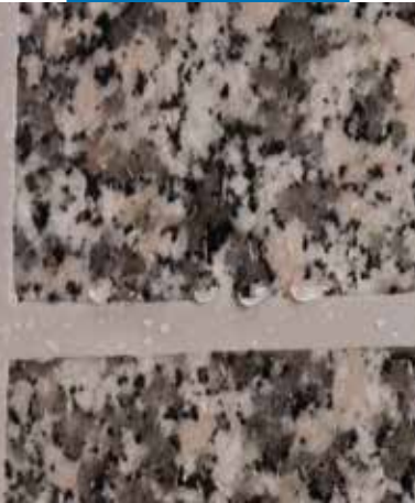
Uszczelnienie okładziny z kamienia naturalnego na zewnątrz
