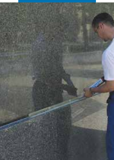
Uszczelnienie dylatacji elewacyjnej z użyciem Mapesil LM
