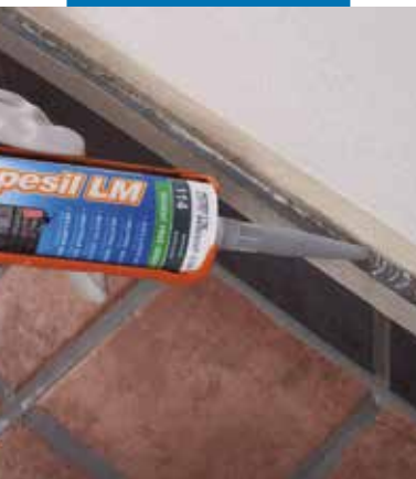
Uszczelnienie okładziny z kamienia naturalnego wewnątrz
