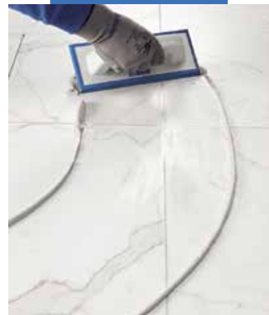
Spoinowanie płytek imitujących kamień naturalny
