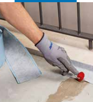
Aplikacja Mapeband SA przy krawędziach
