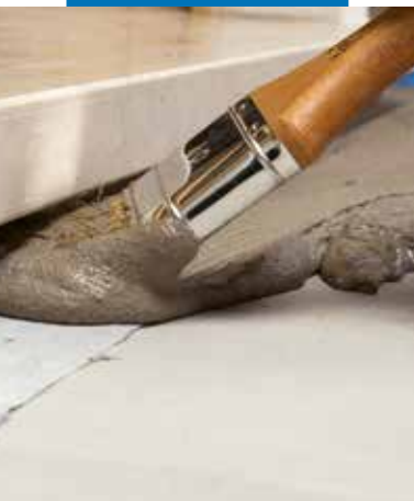
Aplikacja Mapeband SA w trudno dostępnych miejscach
