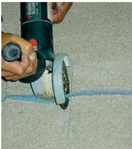
1. Wykonywanie nacięcia w celu włożenia dybla
