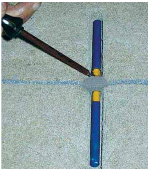
4. Dostosowywanie dybla dylatacyjnego
