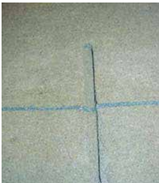
2. Nacięcie przygotowane do instalacji dybla
