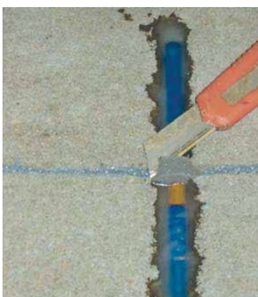
6. Odcinanie nadmiaru pianki ekspansywnej
