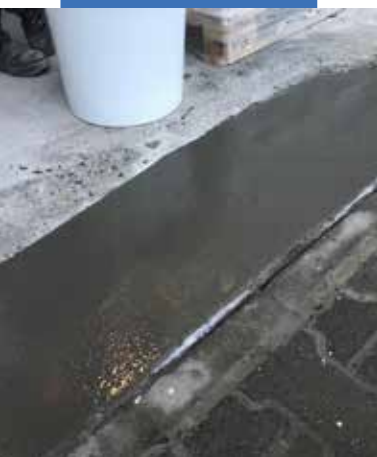
Mapegrout SV Smart wygładzony pacą
