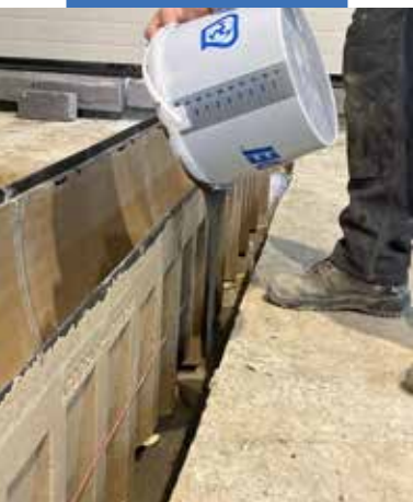
Wlewanie Mapegrout SV Smart do szalunku
