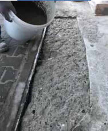
Podłoże betonowe przygotowane do aplikacji Mapegrout SV Smart
