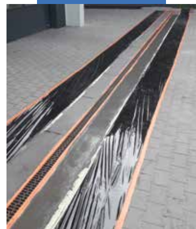
Wykonanie przerw roboczych w zaprawie Mapegrout SV Smart
