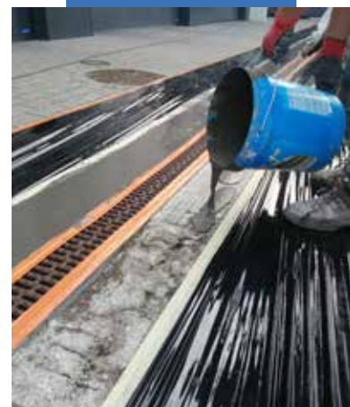
Wylewanie Mapegrout SV Smart na podłoże betonowe
