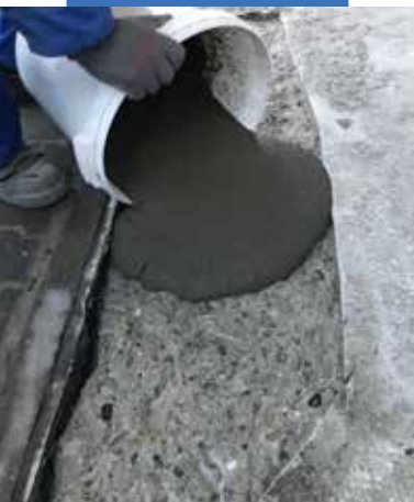
Wylanie Mapegrout SV Smart na podłoże betonowe
