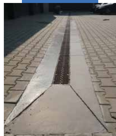
Gotowe odwodnienie osadzone przy użyciu Mapegrout SV Smart
