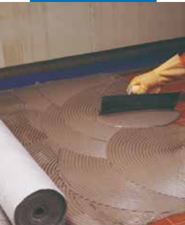
Stopniowe układanie włókniny Mapetex Sel podczas nanoszenia pierwszej warstwy hydroizolacji
