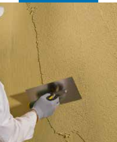
Tynk nakłada się gładką pacą stalową na grubość kruszywa
