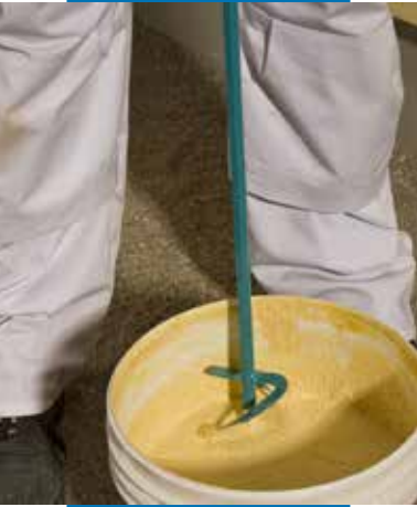
Tynk przed nakładaniem wymieszać do jednolitej konsystencji
