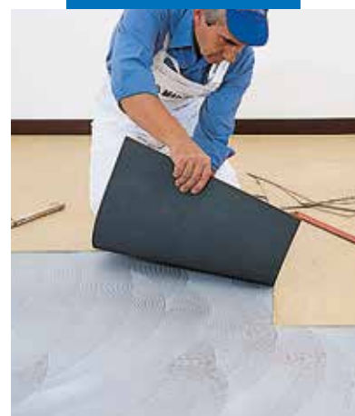
Montaż homogenicznej wykładziny PVC
