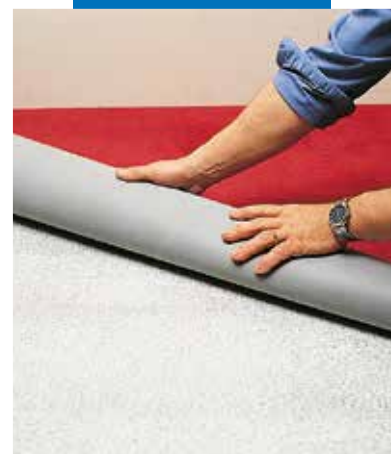
Układanie wykładziny na warstwie kleju
