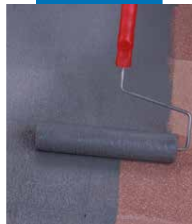
Nanoszenie Eco Prim Grip wałkiem na istniejącą okładzinę lastryko
