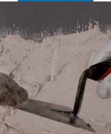
Nanoszenie tynku na Eco Prim Grip
