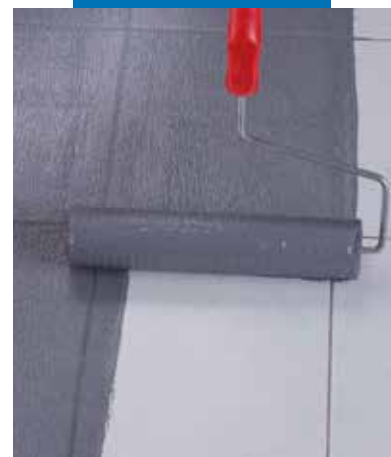
Nanoszenie Eco Prim Grip wałkiem na płytki z gresu porcelanowego
