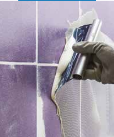
Aplikacja Ultrabond Eco 4 LVT Wall na istniejącym podłożu ceramicznym za pomocą pacy zębatej
