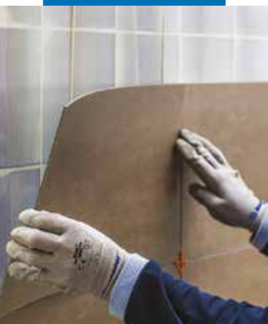
Montaż płytek LVT na ścianie
