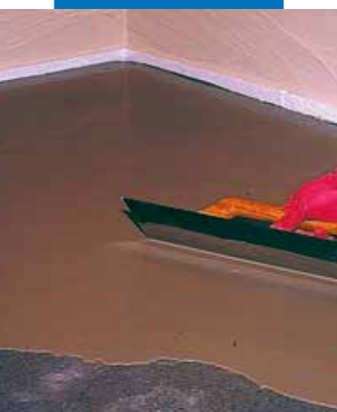
Rozprowadzanie masy Novoplan 21 przy użyciu metalowej szpachli na powierzchni zagruntowanej preparatem gruntującym Primer G Pro
