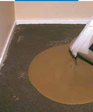
Wylewanie masy Novoplan 21 na podłoże
