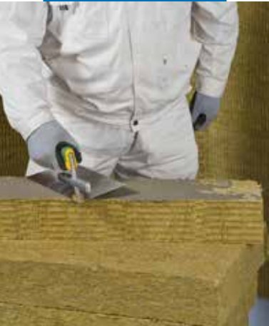
Gruntowanie zaprawą klejową wełny lamelowej
