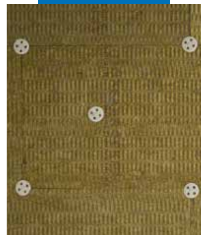
Przykładowe kołkowanie płyty izolacyjnej z wełny mineralnej
