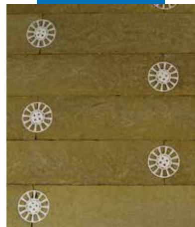
Rodzaj i przykładowe rozmieszczenie kołków na wełnie lamelowej
