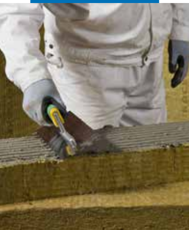
Powierzchnia styku wełny lamelowej z podłożem winna być bliska 100%
