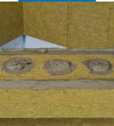
Rozmieszczenie zaprawy do Mapetherm Wool do wełny na płycie wełny mineralnej
