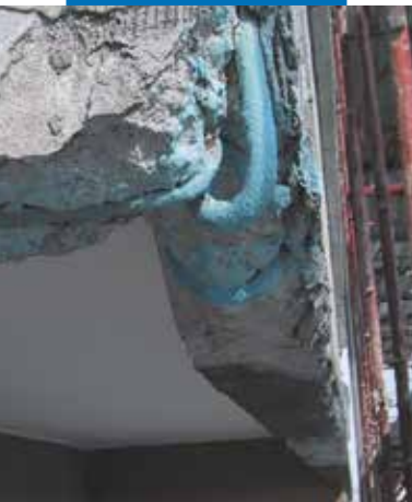
Pręty zbrojeniowe zabezpieczone Mapefer 1K
