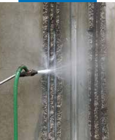
Czyszczenie prętów zbrojeniowych metodą hydropiaskowania
