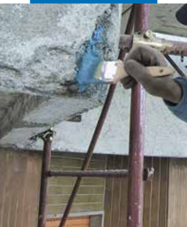
Nakładanie pędzlem Mapefer 1K na oczyszczone pręty zbrojeniowe
