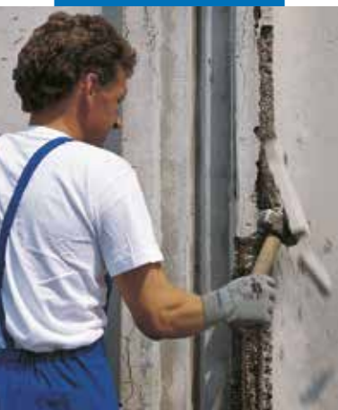
Usuwanie uszkodzonego betonu
