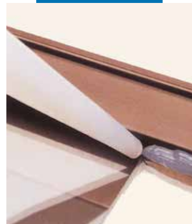
Spoinowanie elementów aluminiowych
