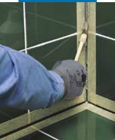
Gruntowanie boków szczeliny przy użyciu Primer FD
