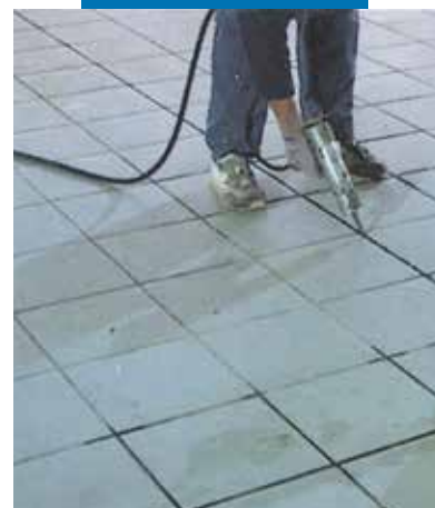
Spoinowanie posadzki za pomocą pistoletu pneumatycznego
