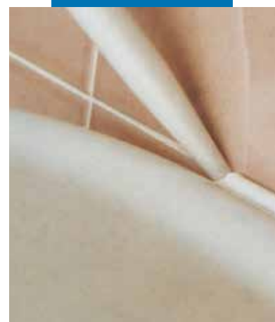
Spoinowanie ceramiki sanitarnej przy użyciu Mapesil AC
