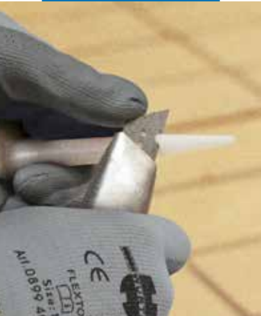
Przycinanie dyszy w zależności od wymiaru szczeliny
