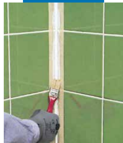
Wyglądanie spoiny za pomocą wody z mydłem i pędzla
