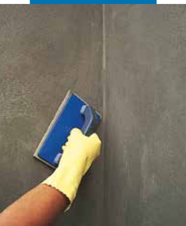
Wykańczanie za pomocą zacieraczki z gąbką
