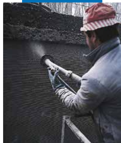
Kanal hydroelektryczny Bertini - Robbiate (Como). Nakładanie zaprawy metodą natryskową
