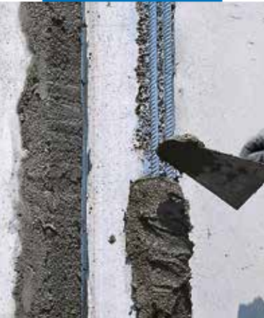
Nakładanie zaprawy przy użyciu kielni
