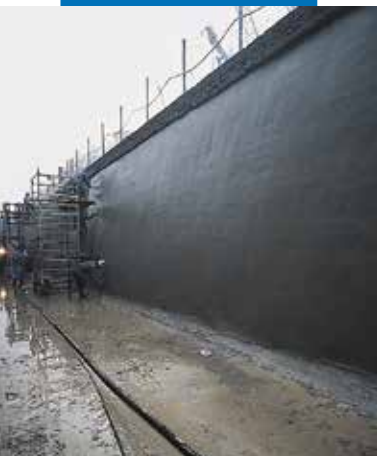
Kanał hydroelektryczny Bertini - Robbiate (Como). Widok ogólny
