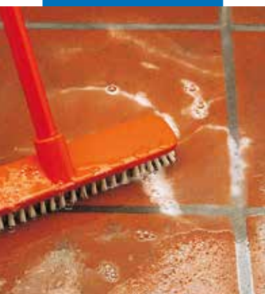
Czyszczenie zabrudzeń za pomocą szczotki
