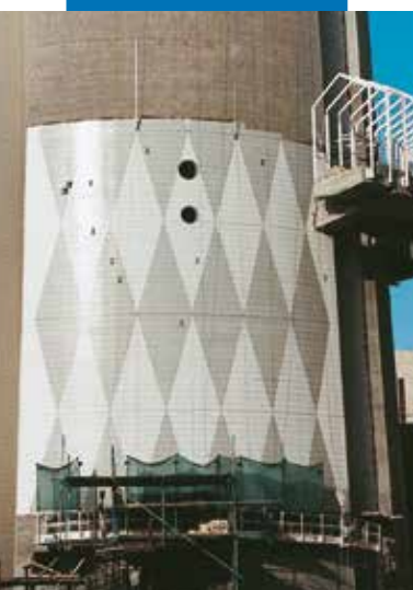
Montaż klinkieru na betonie, z zastosowaniem Kerabond + Isolastic - New Telecommunication Tower - Kuwait City (Kuwejt)
