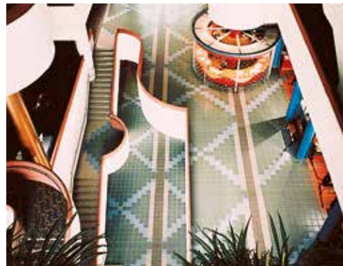
Montaż gresu porcelanowego z użyciem Kerabond T + Isolastic - Civic Center - North York Ontario (Kanada)
