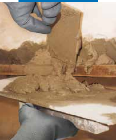
Naprawa gzymsów balkonowych: Nanoszenie Planitop 400
