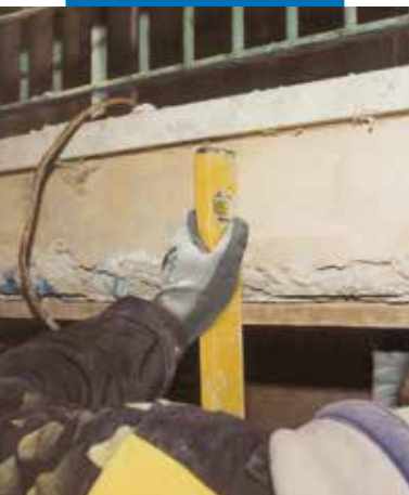
Naprawa gzymsów balkonowych: montaż deskowania
