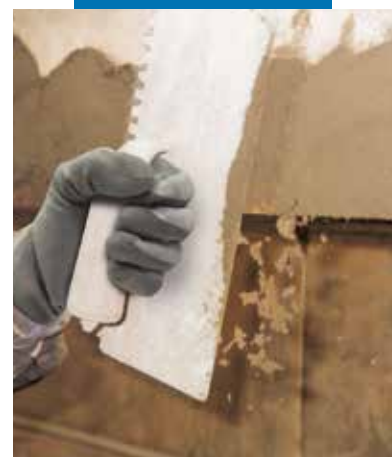
Naprawa gzymsów balkonowych: wygładzanie
