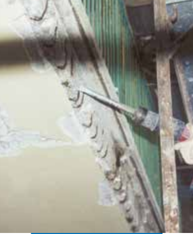
Naprawa gzymsów balkonowych: przygotowanie podłoża
