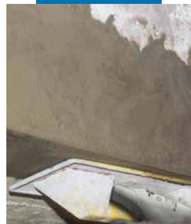
Naprawa krawędzi belek betonowych
