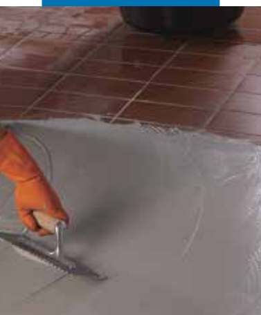
Nakładanie drugiej warstwy Monolastic na Mapenet 150
