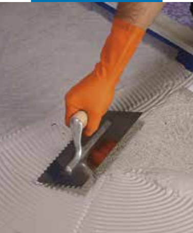
Nakładanie pierwszej warstwy Monolastic na Mapetex Sel na nowym jastrychu
