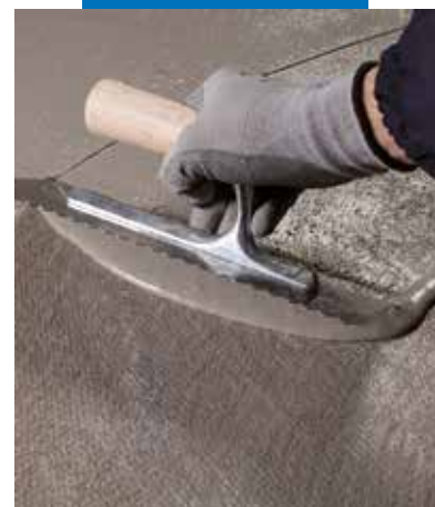
Aplikacja drugiej warstwy Mapelastik Turbo na pierwszą wzmocnioną Mapetex Sel
