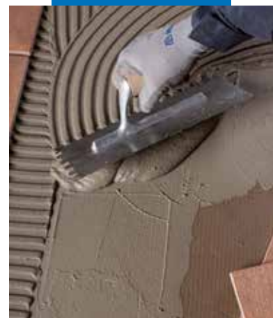
Przyklejanie płytek za pomocą zaprawy klejącej Elastorapid
