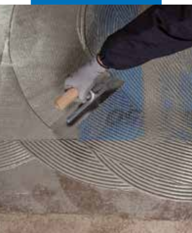
Wtapienie siatki Mapenet 150 w pierwszą, jeszcze świeżą warstwę Mapelastic Turbo
