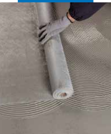
Układanie Mapetex Sel na pierwszej, jeszcze świeżej warstwie Mapelastic Turbo
