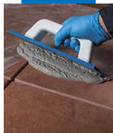
Spoinowanie płytek zaprawą do spoinowania Ultracolor Plus
