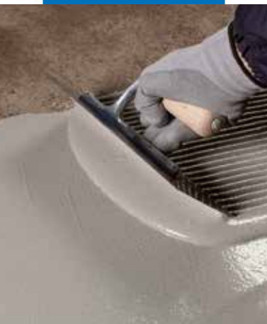
Nakładanie pierwszej warstwy Mapelastic Turbo
