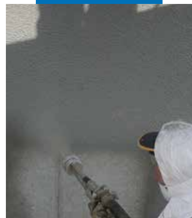
Nanoszenie Mapelastic metodą natryskową
