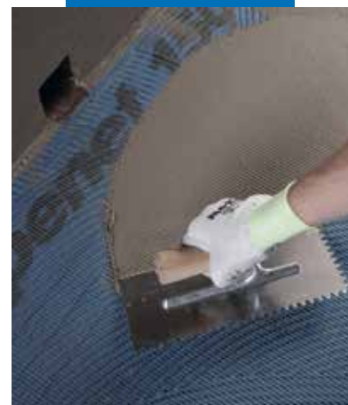
Rozprowadzanie hydroizolacji Mapelastic na siatce Mape-net 150
