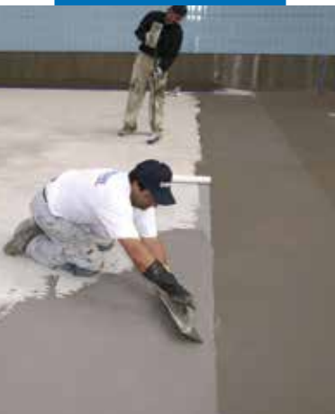
Hydroizolacja basenu z zastosowaniem Mapelastic
