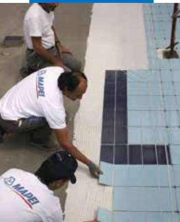
Montaż płytek ceramicznych na warstwie hydroizolacji Mapelastic
