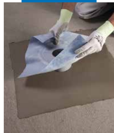
Montaż Drain Vertical na Mapelastic
