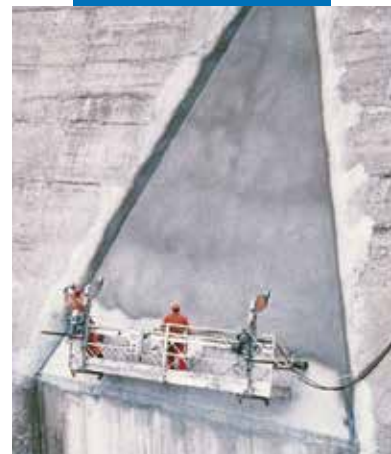
Nanoszenie Mapelastic metodą natryskową na zaporze wodnej
