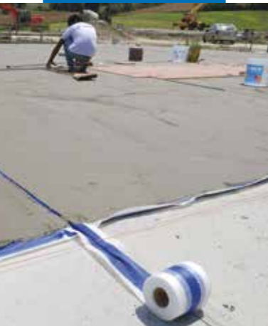
Hydroizolacja powierzchni jastrychów z zastosowaniem Mapelastic i Mapeband
