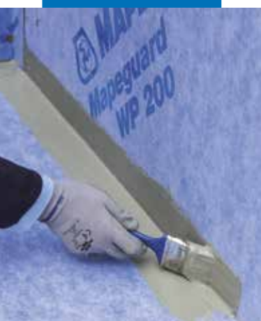
Rozprowadzanie kleju Mapeguard WP Adhesive przed uszczelnieniem naroży taśmą Mapeguard ST
