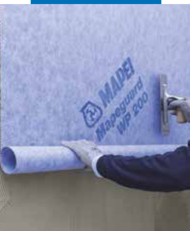
Układanie Mapeguard WP 200
