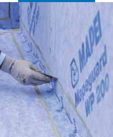
Przyklejanie taśmy Mapeguard ST
