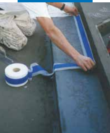
Uszczelnianie taśmą Mapeband naroża w strefie przybasenowej
