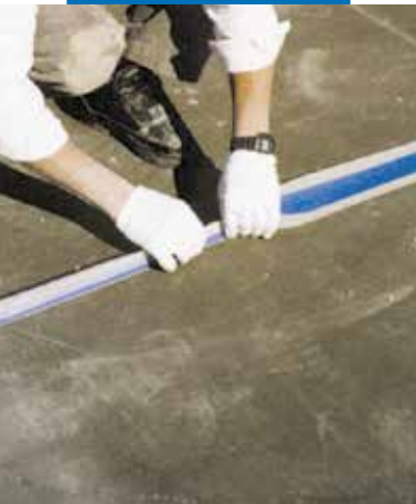
Przykład uszczelnienia dylatacji tarasu przy użyciu taśmy Mapeband
