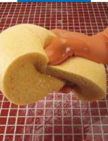
Zwilżanie wodą zaspoinowanej powierzchni przed czyszczeniem
