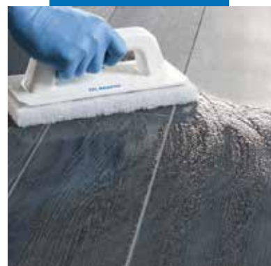
Wstępne czyszczenie powierzchni płytek gąbką Scotch Brite®
