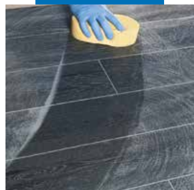
Czyszczenie i profilowanie spoin gąbką celulozową MAPEI
