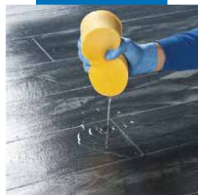
Zwilżanie wodą zaspoinowanej posadzki przed czyszczeniem
