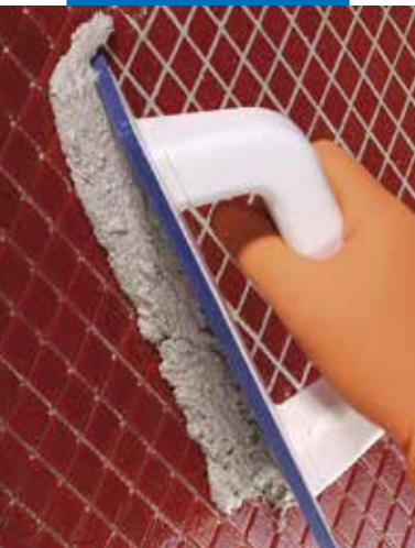
Spoinowanie mozaiki szklanej z użyciem Kerapoxy Design
