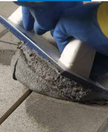
Nakładanie Kerapoxy CQ pacą MAPEI
