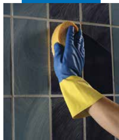
Czyszczenie i profilowanie celulozową gąbką MAPEI
