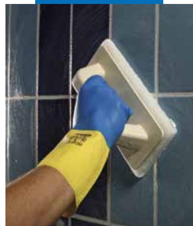
Czyszczenie Kerapoxy CQ wodą przy użyciu pacy Scotch-Brite®
