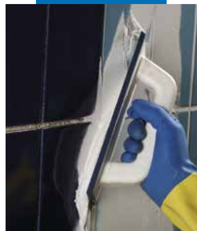
Nakładanie Kerapoxy CQ pacą MAPEI
