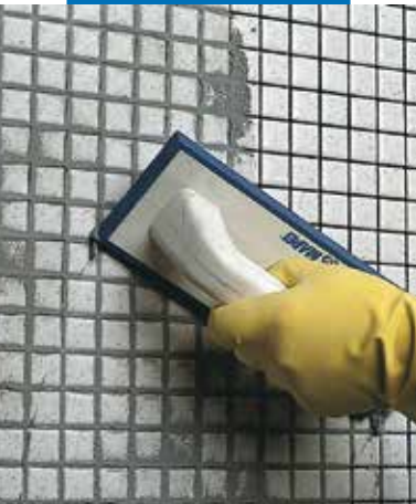
Spoinowanie mozaiki szklanej pacą
