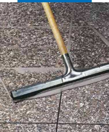
Spoinowanie wyrównanego i wypolerowanego granitu gumową rakłą
