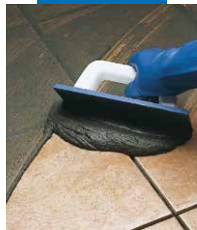
Spoinowanie płytek gumową pacą
