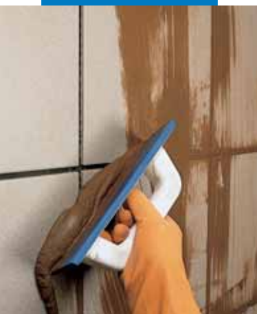
Spoinowanie płytek zewnętrznych przy użyciu pacy
