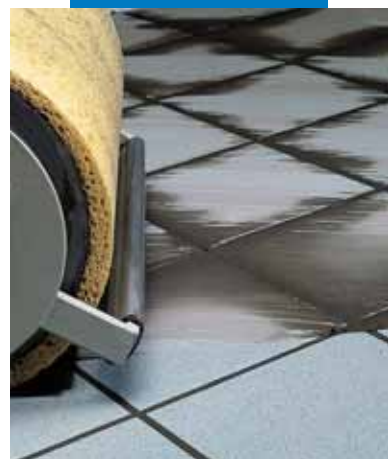
Maszynowe czyszczenie podłoża po spoinowaniu
