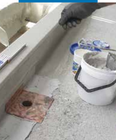
Wklejanie kołnierza miedzianego do wykonania odpływu
