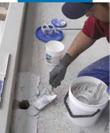
Nakładanie Adesilex PG4 szpachelką
