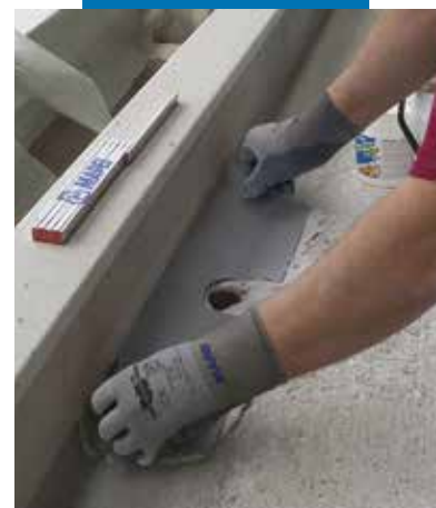
Wklejanie elastycznej taśmy hypalonowej
