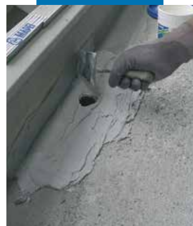
Nakładanie końcowej warstwy Adesilex PG4
