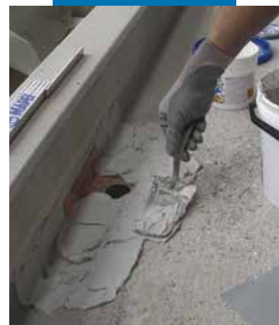
Nanoszenie kleju na wierzch kołnierza odplywowego
